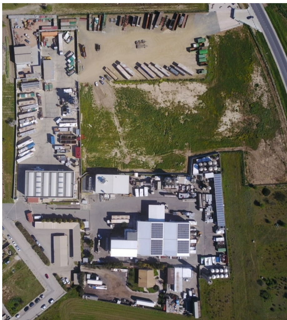
Figura 1 - Vista aerea stabilimento
